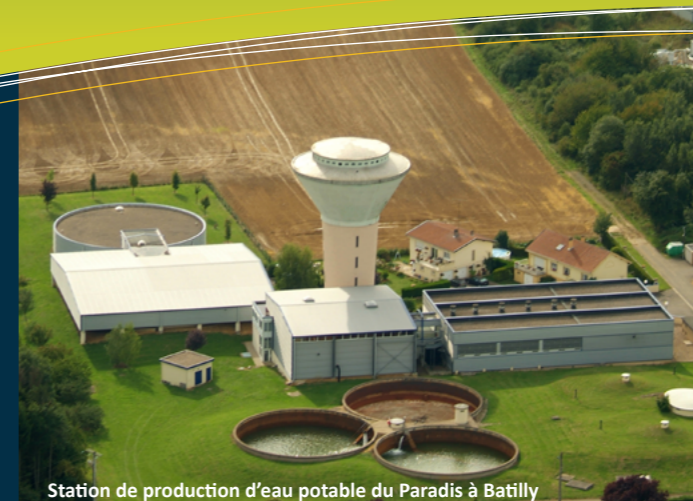
Station de production d'eau potable du Paradis à Batilly
